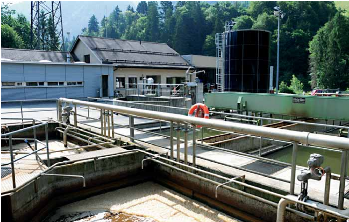
Die Abwasserreinigungsanlage Vorderes Prättigau in Seewis-Pardisla heute.
