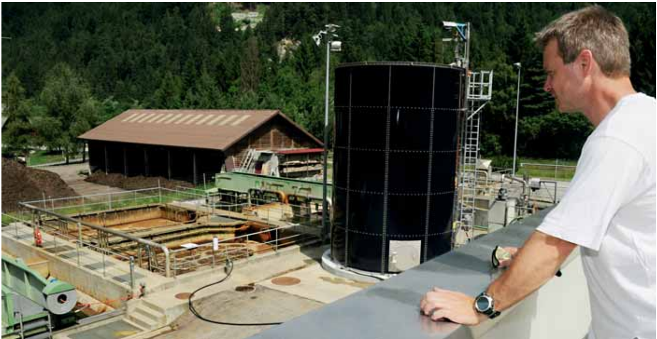
Peter Sutters Reich, die Abwasserreinigungsanlage Vorderes Prättigau.
